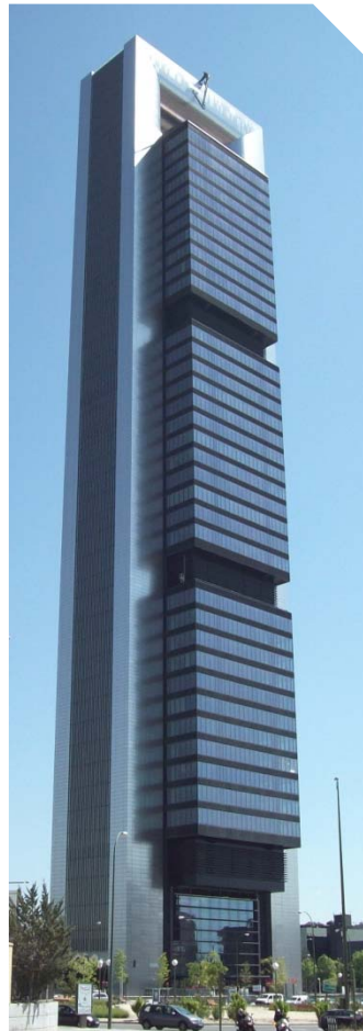
TORRE CEPESA EN PROCESO
